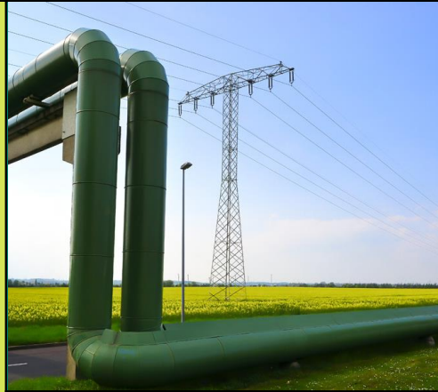
Strom, Gas, Wärme
