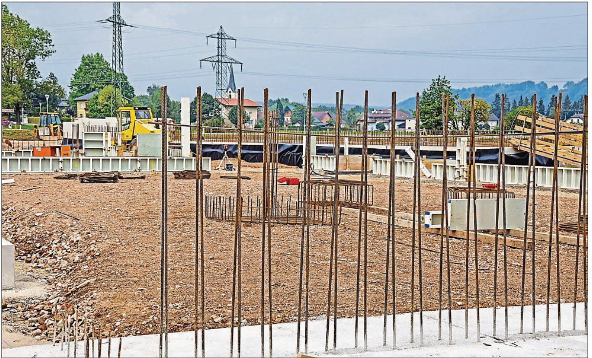
Kommt es zu Verzögerungen auf der Baustelle, sind häufig Vertragsstrafen zu zahlen.
