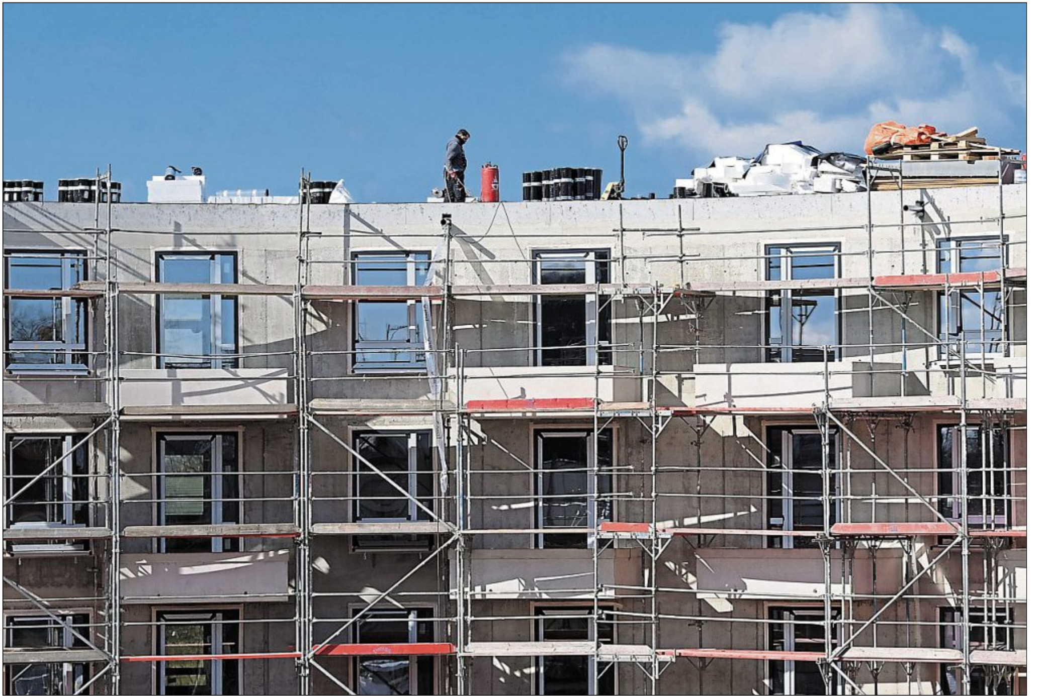
Um die Ausschreibung von Rohbauarbeiten für den Neu- und Umbau einer Funktionsdiagnostik gab es Streit.
