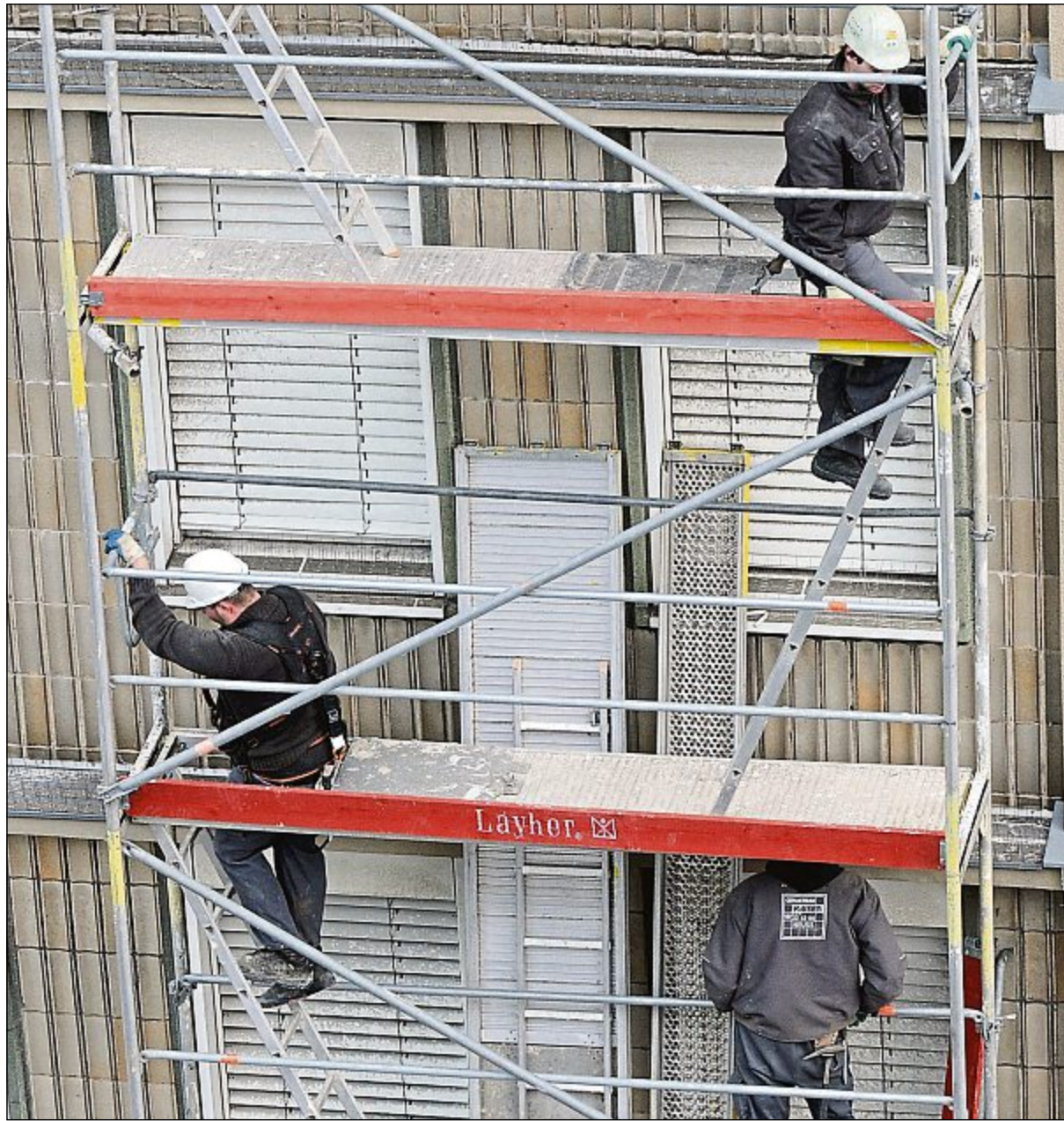
Unter anderem wegen Gerüstbauarbeiten gab es Streit.
