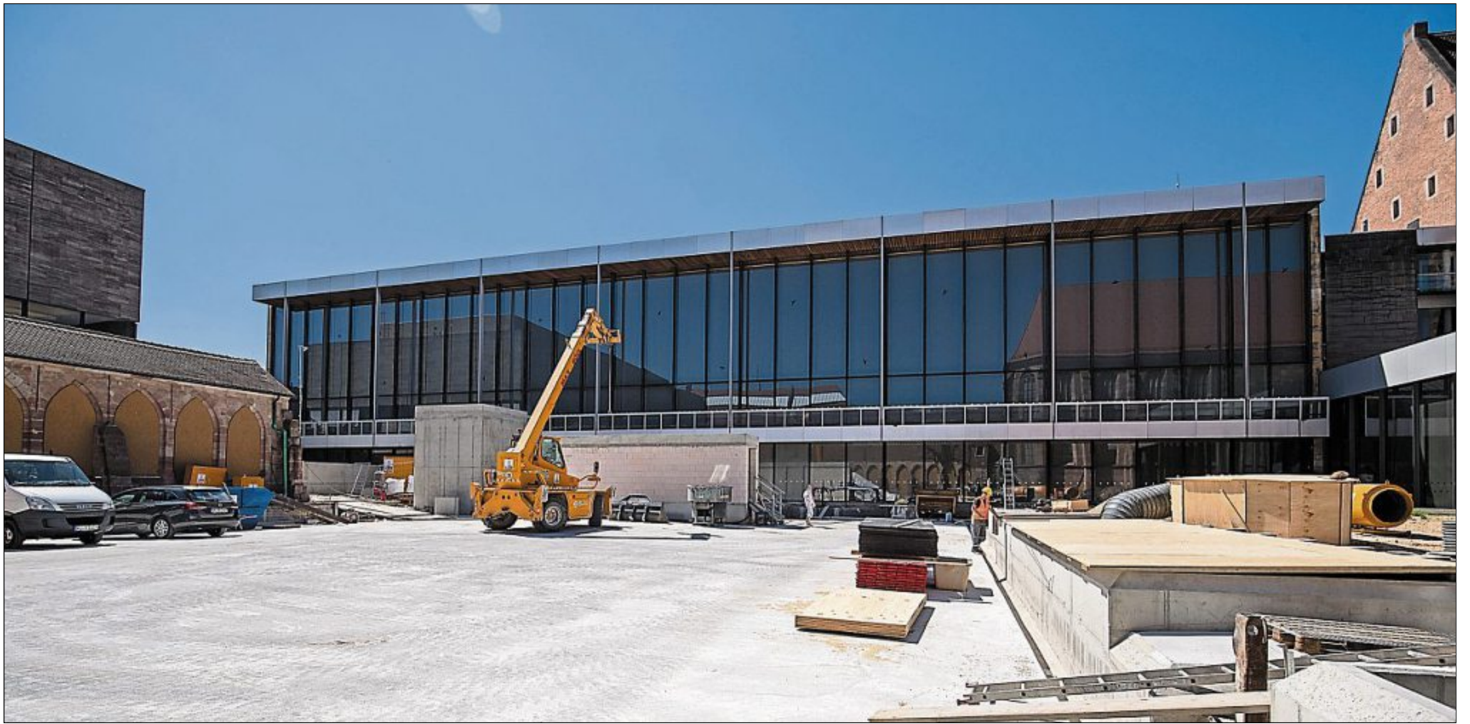
Öffentliche Bauprojekte müssen dokumentiert werden.
