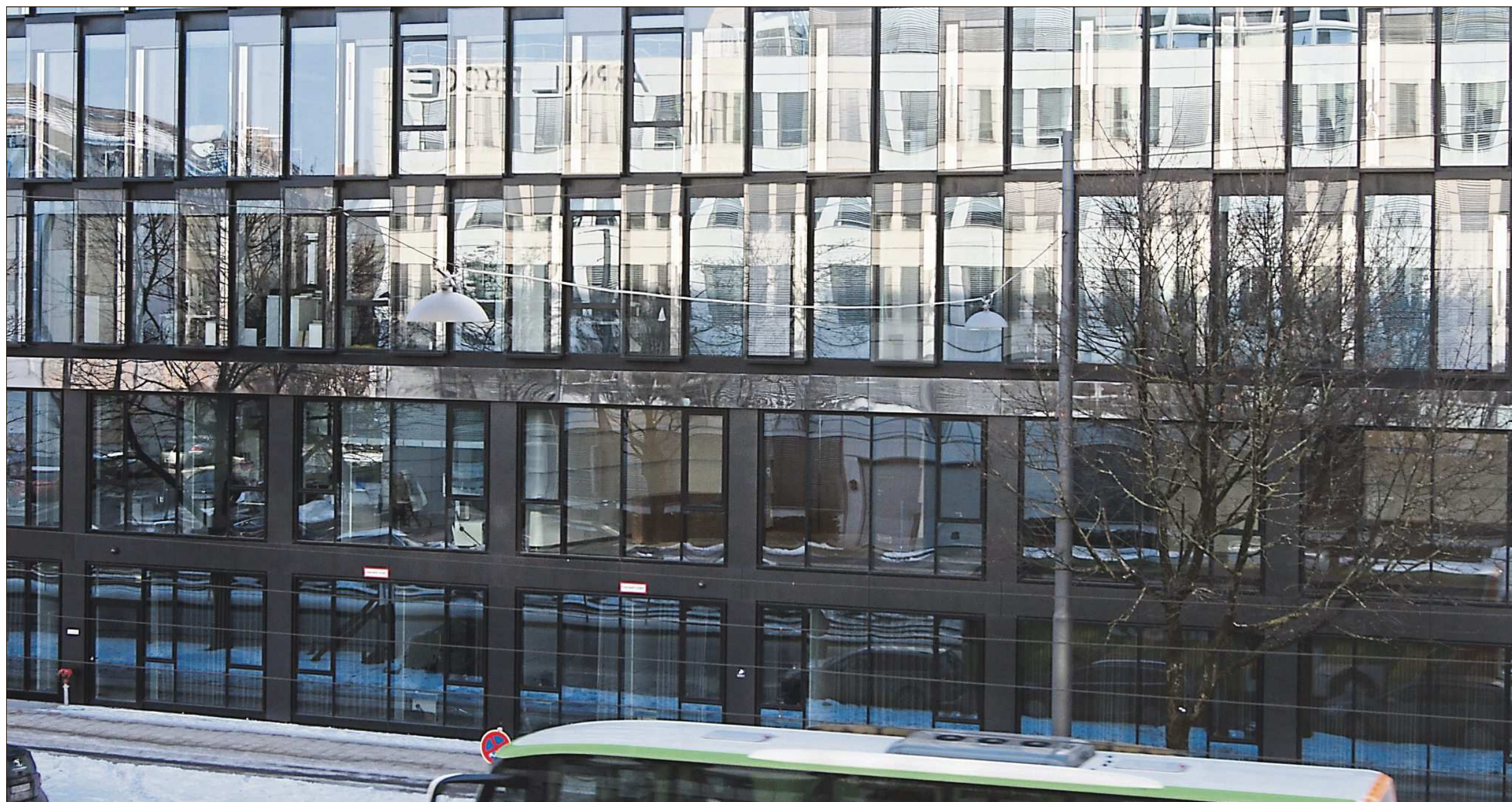
Um die europaweite Ausschreibung für die Errichtung von zirka 450 Quadratmetern verglaste Aluminium-Pfosten-Riegelkonstruktionen für Fassaden gab es Streit.
