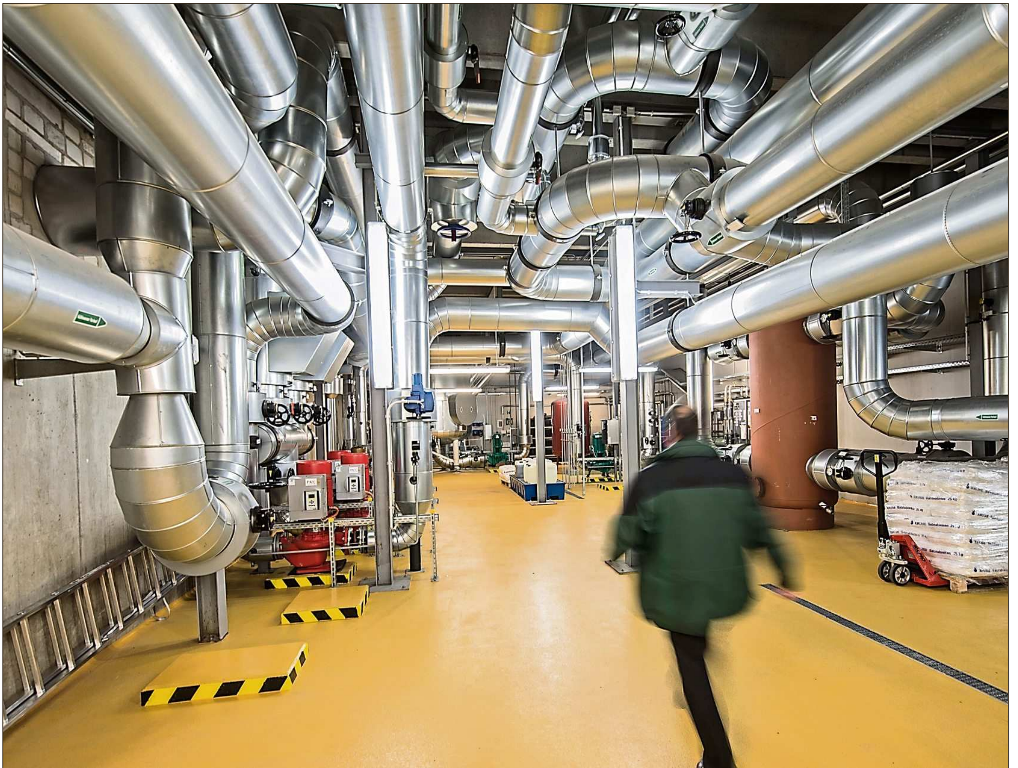
Bei der europaweiten Ausschreibung von Lüftungstechnikleistungen gab es Streit.
