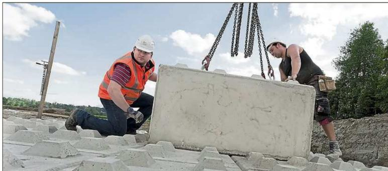
Ein Bauingenieur und ein Arbeiter setzen Steine für eine Probelastungsmessung. FOTO DPA
