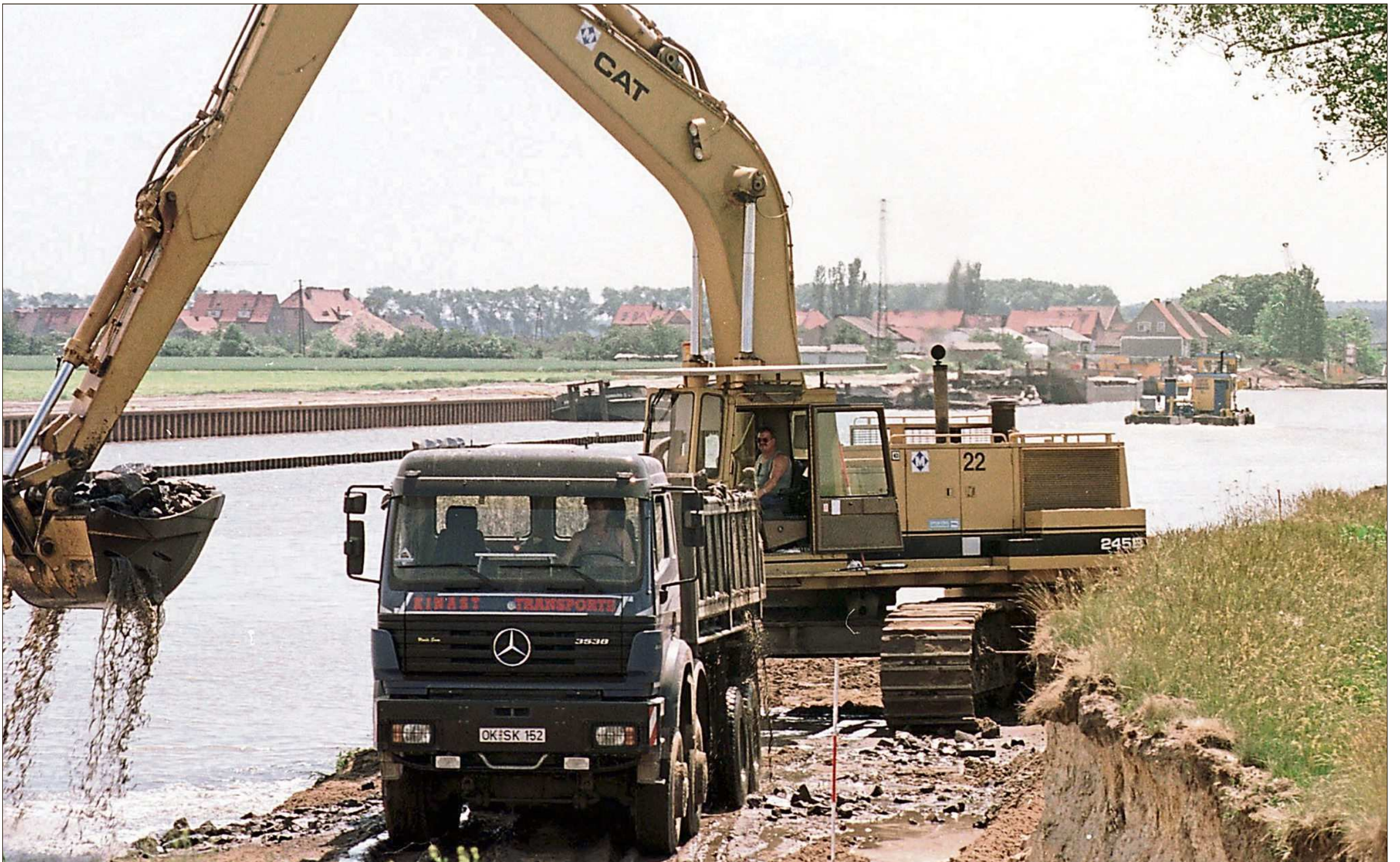
Bei Ausschreibung von Baggerarbeiten an einem Kanal gab es Streit.
