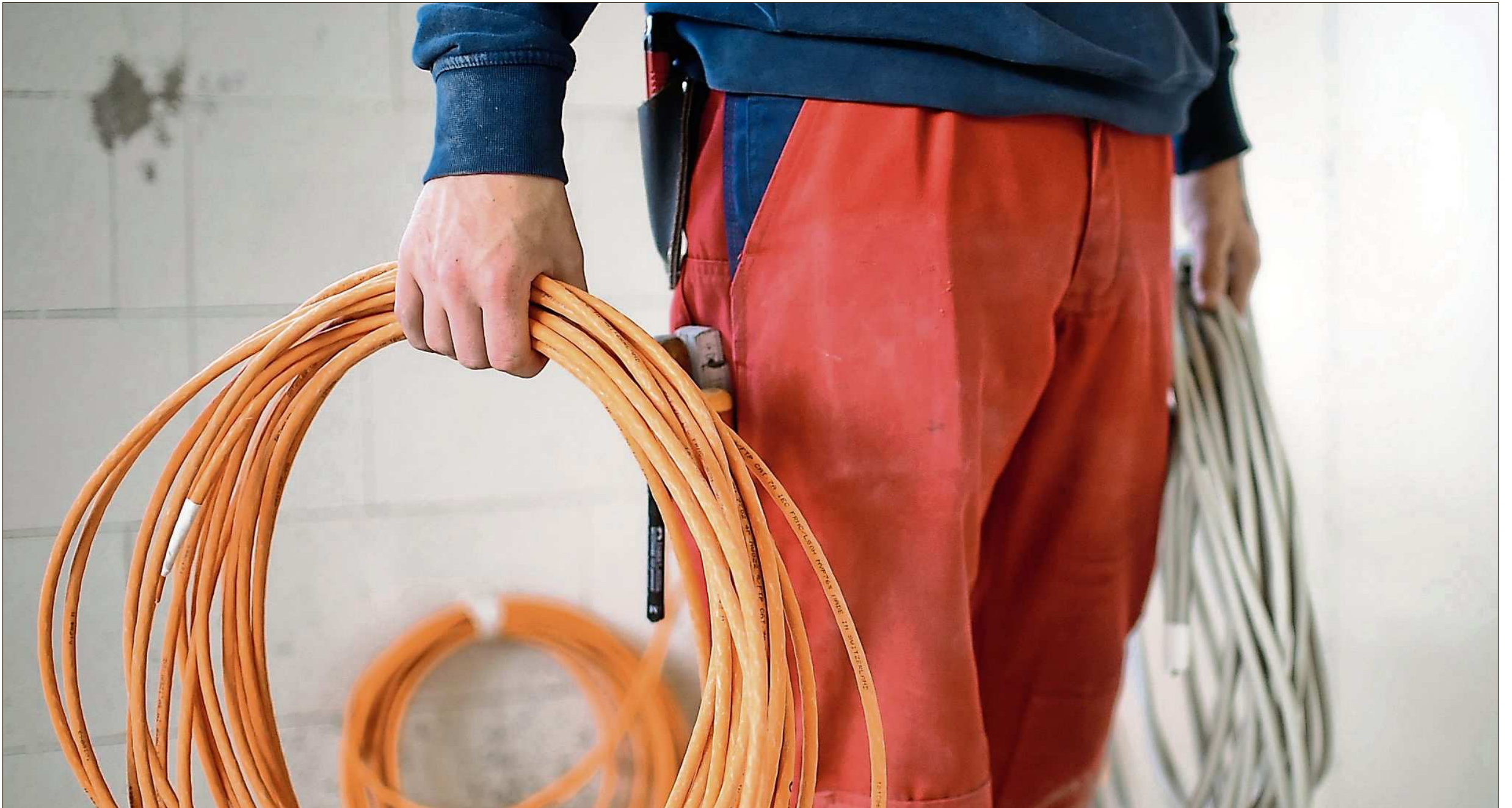
Bei der deutschlandweiten Vergabe von Elektroninstallationsarbeiten gab es Streit.
