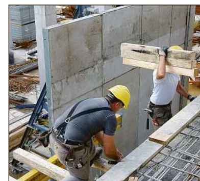
Bis gebaut werden kann, müssen die Hürden der Vergabe überwunden sein. FOTO DPA
