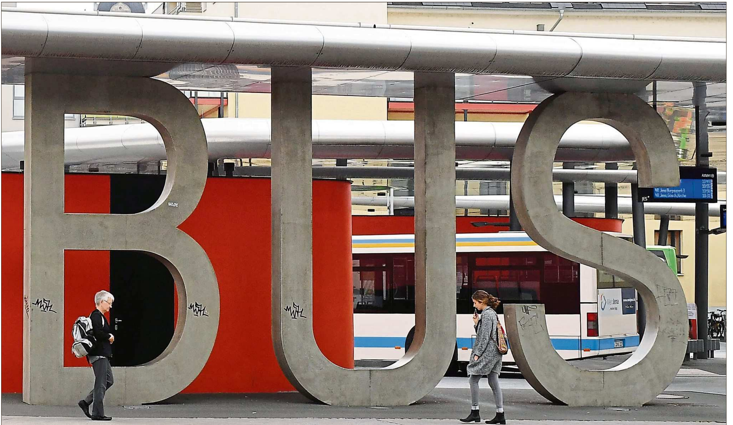
Um die Ausschreibung zur Umgestaltung eines Zentralen Omnibusbahnhofs gab es Streit.
