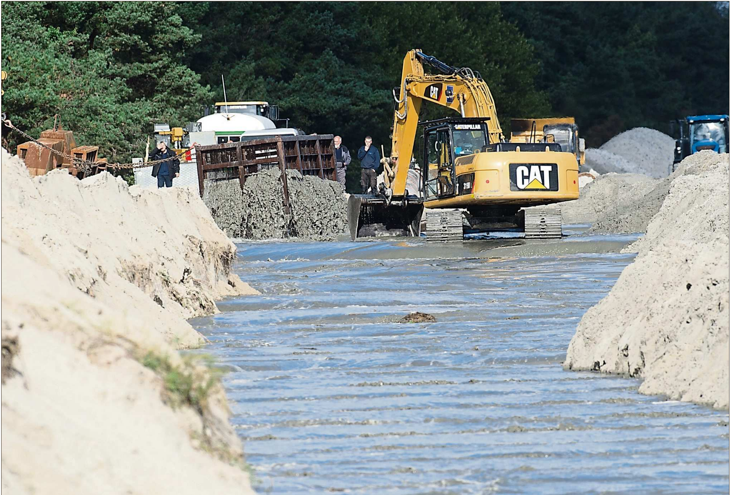
Um die Vergabe von Baggerarbeiten gab es Streit.
