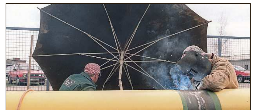
Beim Rohrleitungsbau gab es Vergabeprobleme.
