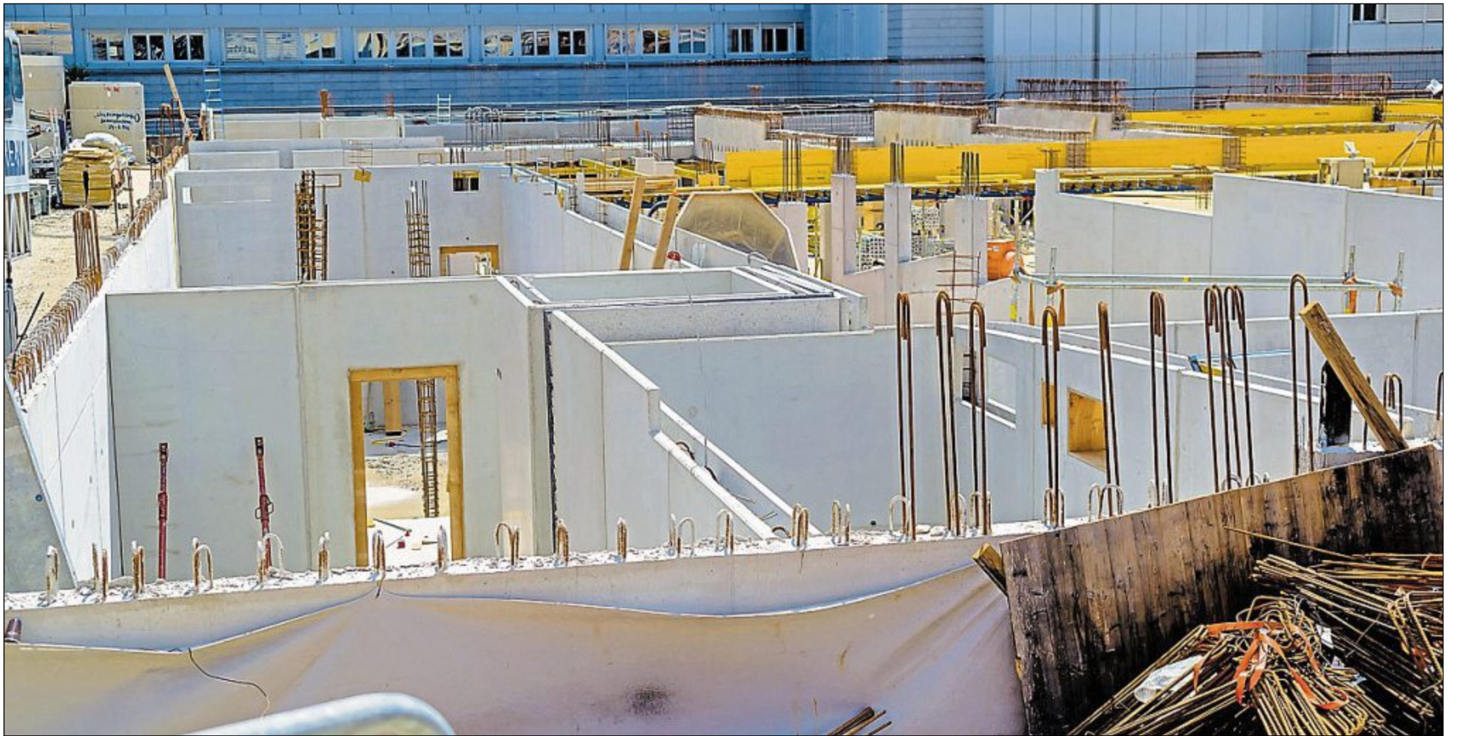
Um Rohbauarbeiten für die Neuerrichtung eines Gymnasiums gab es Streit.
