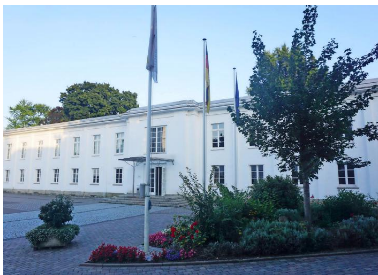
Auch die Abweichung von einer Bewerbungsbedingung ist eine Änderung an den Vergabeunterlagen. Das hat die Vergabekammer des Bundes klargestellt. FOTO: DPA
