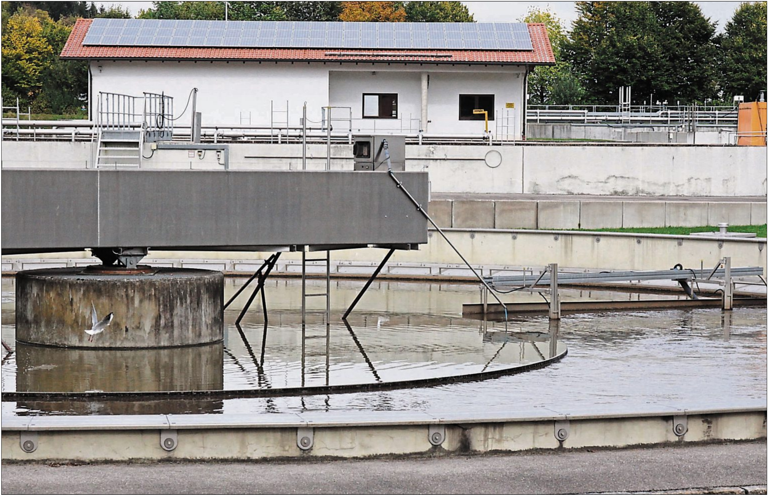
Um die Erweiterung einer Kläranlage (Symbolbild) gab es Streit.
