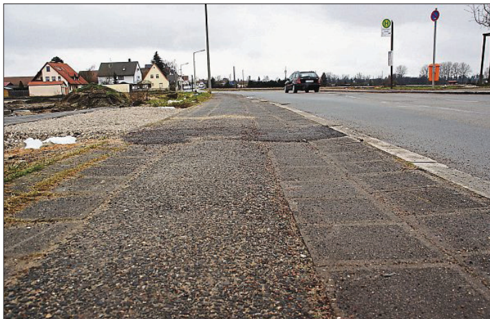
Unebenheiten auf Gehwegen dürfen maximal 2,5 Zentimeter betragen.
